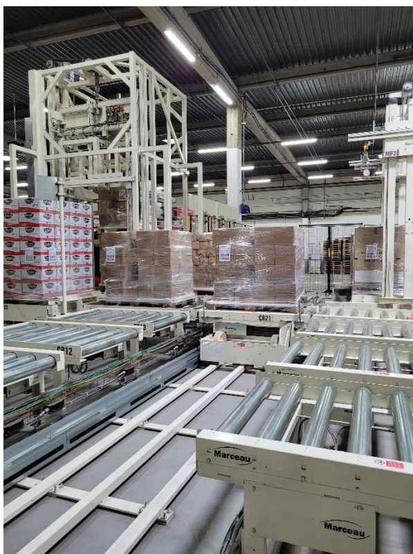
11944 210 Navette de regroupement palettes pour alimentation poste de gerbage
