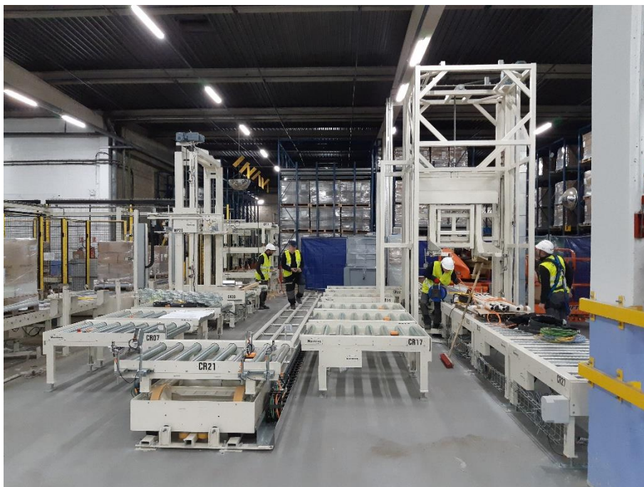
11944 078 Chantier réalisé simultanément avec la production
