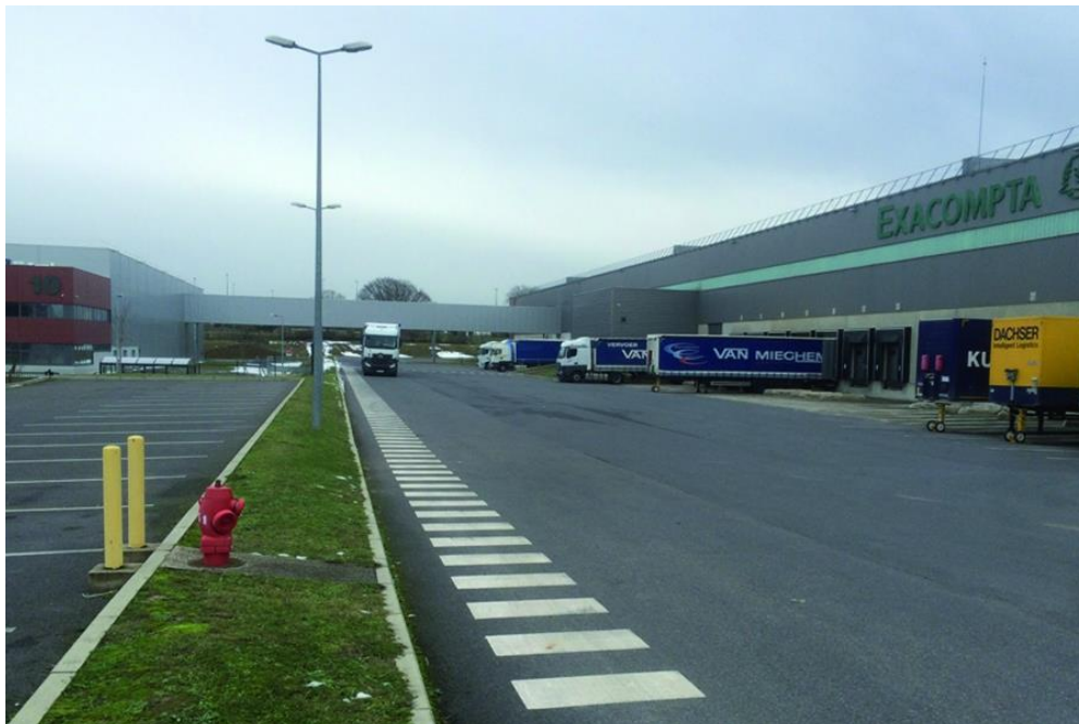
Passerelle de liaison inter-bâtiment
