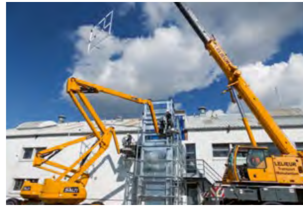
Pose d'un Montepal®
