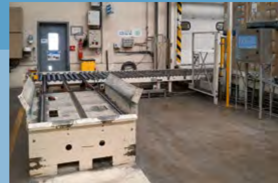
Rénovation et amélioration d'une entrée de ligne
