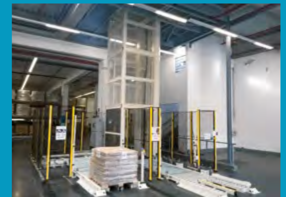
EL 80 Élévateur pour liaison inter-halls.
