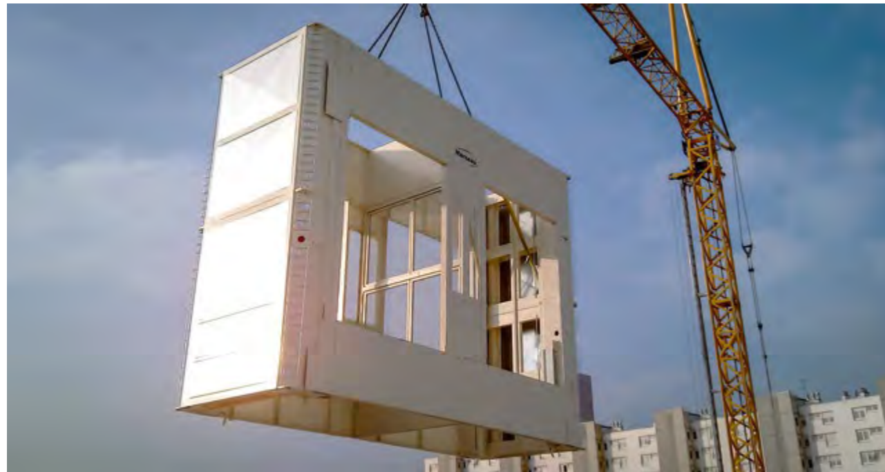
Grutage d'un Montepal®
